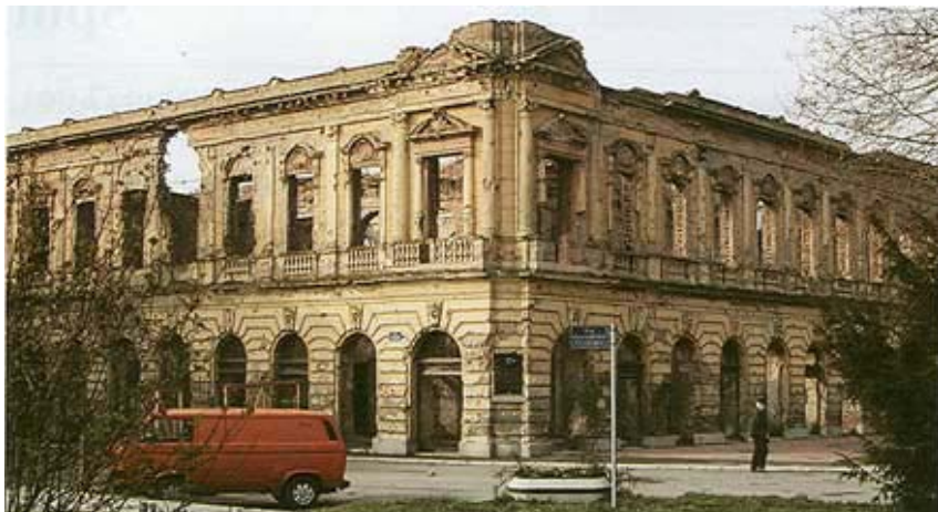
Zgrada Radničkog doma u Vukovaru pred obnovom
