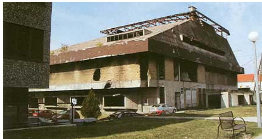
Devastirana još neobjavljena robna kuća u Vukovaru
